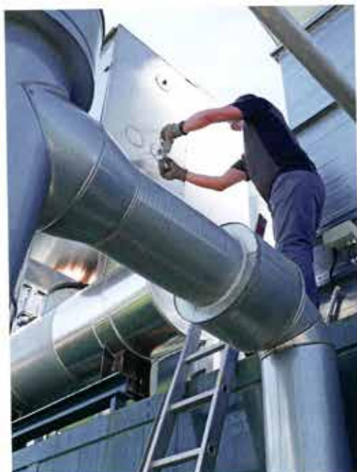
Das Messgerät muss in einem bestimmten Winkel positioniert werden.
