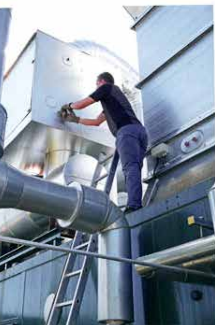
Um an den Katalysator zu gelangen, muss mitunter die Verkleidung abgeschraubt werden.
