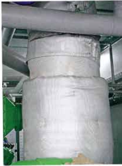
Das Abgas sollte nach dem Abgaswärmetauscher gemessen werden. Dort ist das Abgas kühler.
